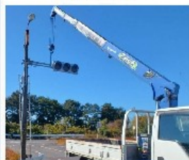
信号灯器 更新工事
