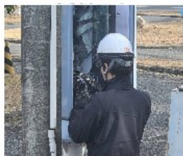
信号制御機 更新工事
